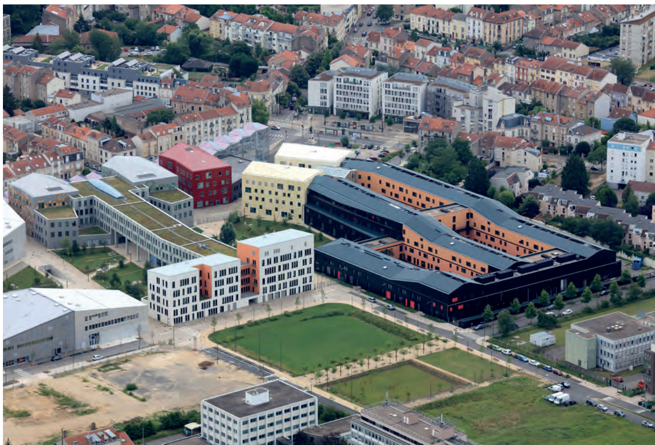
Vue aérienne de l'UL - juin 2018 © Solorem
